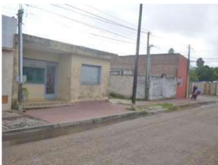
Postes de madera existentes y otros con riesgo de caída
